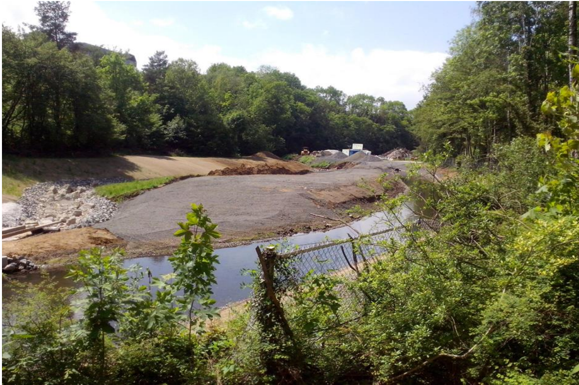
Abbildung 14: Überblicksfoto über den Planungsbereich 1 Felsensägmühle
