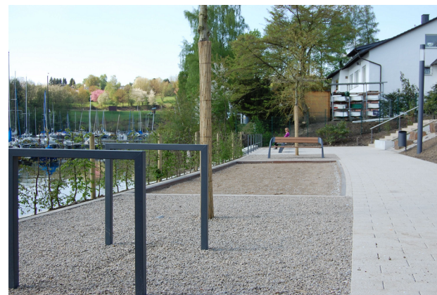
Fahrradparker als Anlehnbügel, L 90/H 90 cm auf Gehrung verschweißt, feuerverzinktes Quadratrohr 50/50 mm, Fundamentierung
