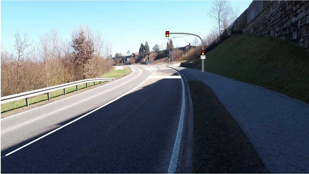
Abbildung 03, Neue Zuflussregelung Brennerstraße/ Geislinger Str. (LE48), neue Lichtsignale
