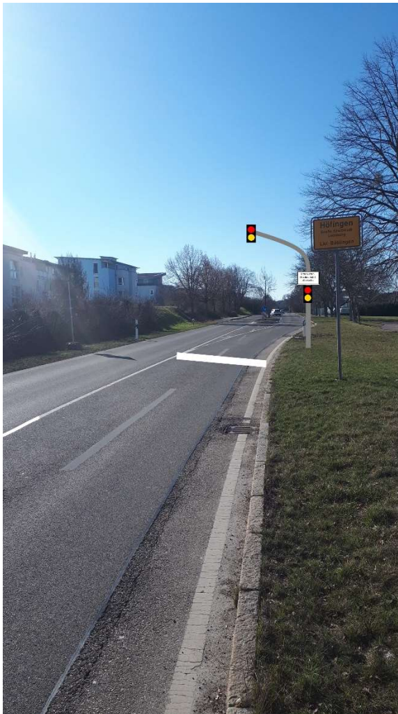
Abbildung 11: neue Zuflussregelung Ditzinger Str., (LE67), Höfingen, neue Lichtsignale
