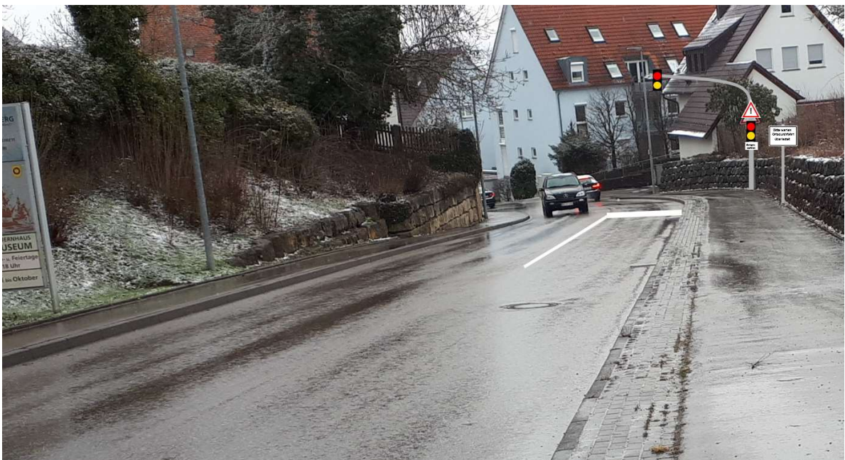
Abbildung 12: neue Zuflussregelung Alte Dorfstraße (LE73), Gebersheim, neue Lichtsignale
