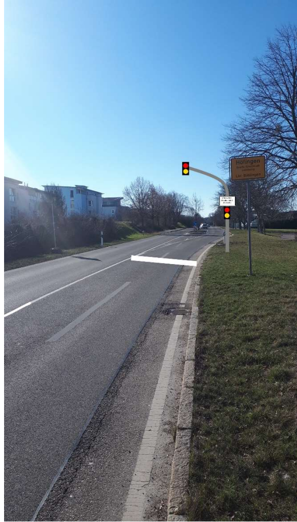
Abbildung 11: neue Zuflussregelung Ditzinger Str., (LE67), Höfingen, neue Lichtsignale
