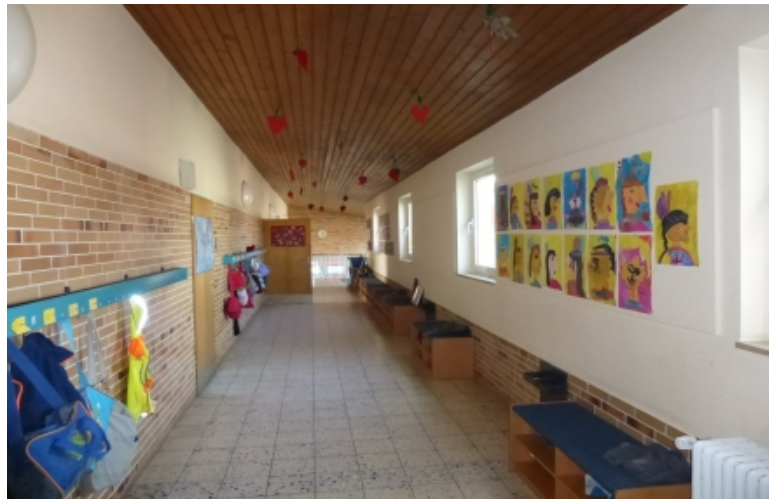
Flurbereich Obergeschoss vor der Sanierung
