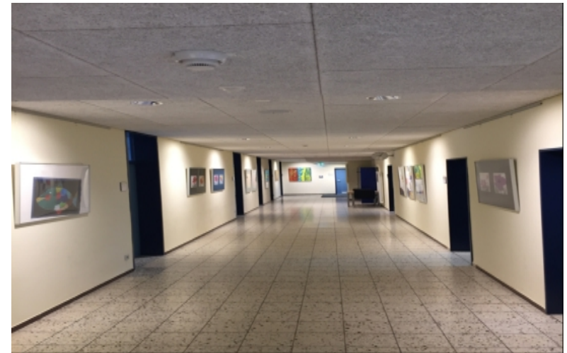
Flurbereich Erdgeschoss nach der Sanierung
