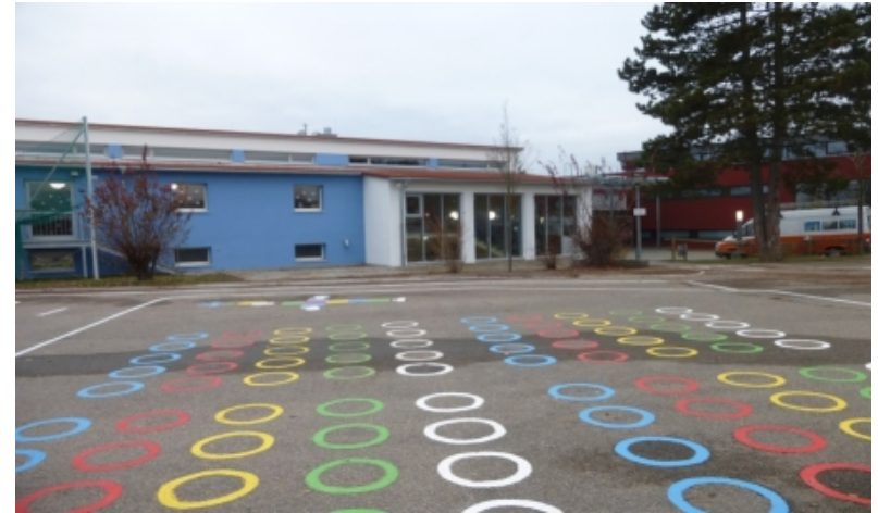
Fassade nach der Sanierung mit Schulhof
