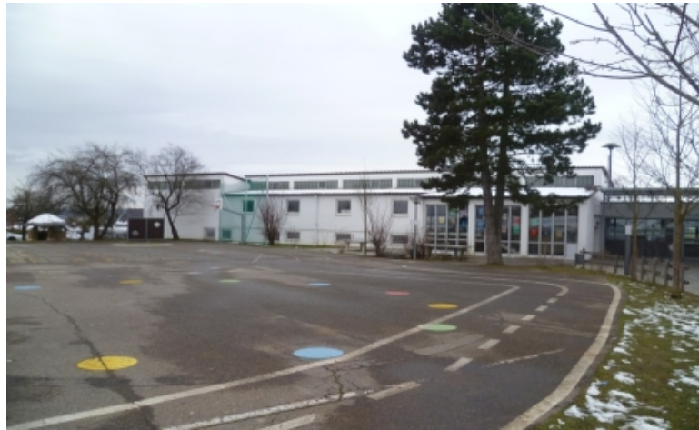
Fassade vor der Sanierung
