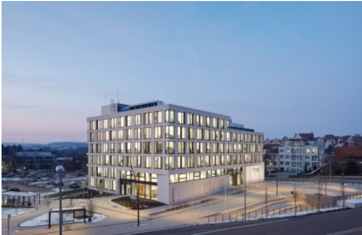
Außenansicht vom Rathausvorplatz
