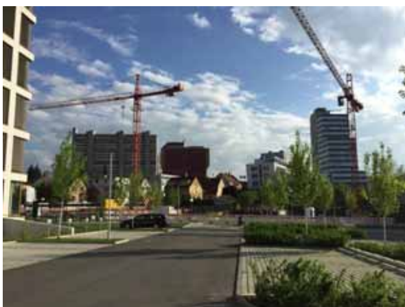
Blick zum Bauvorhaben Seniorenzentrum Quelle: die STEG, 2018
