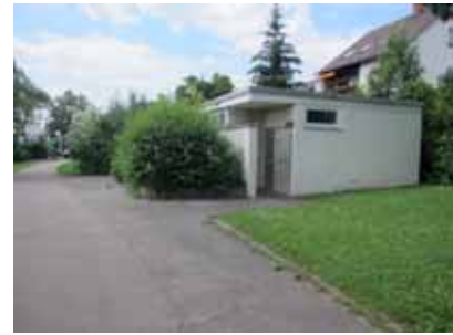
Öffentliche WC-Anlage Quelle: die STEG, 2018
