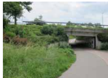
Unterführung Berliner Straße Quelle: die STEG, 2018
