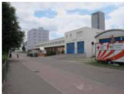
Feuerwache, nördliche Ansicht mit kommunalem Wohngebäude im Hintergrund Quelle: die STEG, 2018
