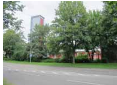
Feuerwache, südliche Gebäudeansicht Quelle: die STEG, 2018
