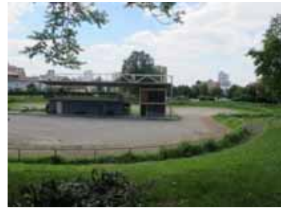
Tribünenbau, Rückwärtige Ansicht Quelle: die STEG, 2018
