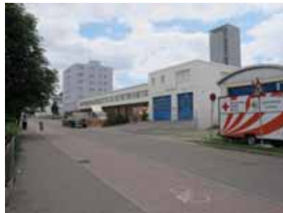
Feuerwache, nördliche Gebäudeansicht mit kommunalem Wohngebäude Quelle: die STEG, 2018
