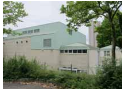
Stadthalle, östliche Ansicht Quelle: die STEG, 2018
