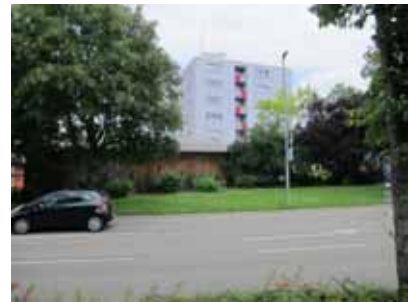
Kommunales Wohngebäude auf Areal Feuerwache Quelle: die STEG, 2018
