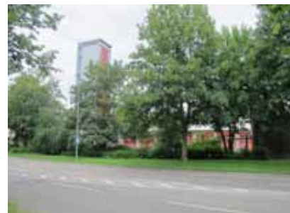
Feuerwache, südliche Ansicht Quelle: die STEG, 2018
