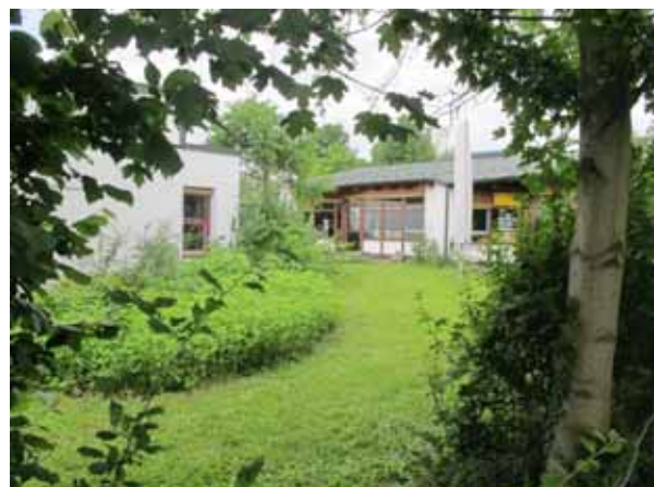
Karl-Georg-Haldenwang-Schule Quelle: die STEG, 2018
