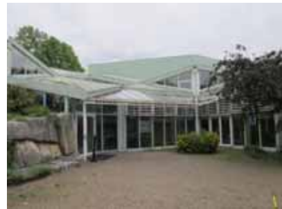
Stadthalle Leonberg 1982-1983 Flacher Baukörper in Hanglage mit bewegter Dachlandschaft. Das Gebäude öffnet sich zum Stadtpark hin. Betontragwerk, darauf Holzskelett, das das Aluminium trägt Quelle: die STEG, 2018
