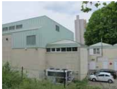
Stadthalle, östliche Gebäudeansicht Quelle: die STEG, 2018
