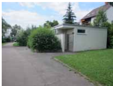
Öffentliche WC-Anlage Quelle: die STEG, 2018
