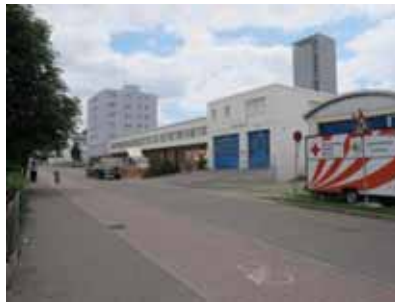
Feuerwache Leonberg, im Vordergrund Gebäude des DRK-Kreisverbands, im Hintergrund kommunales Wohngebäude Quelle: die STEG, 2018
