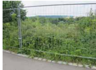
Mangelhafte Hangsicherung Quelle: die STEG, 2018
