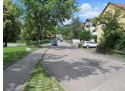
Fichtestraße Quelle: die STEG, 2018
