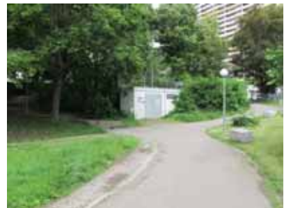
Trafostation am westlichen Stadtpark- rand Quelle: die STEG, 2018
